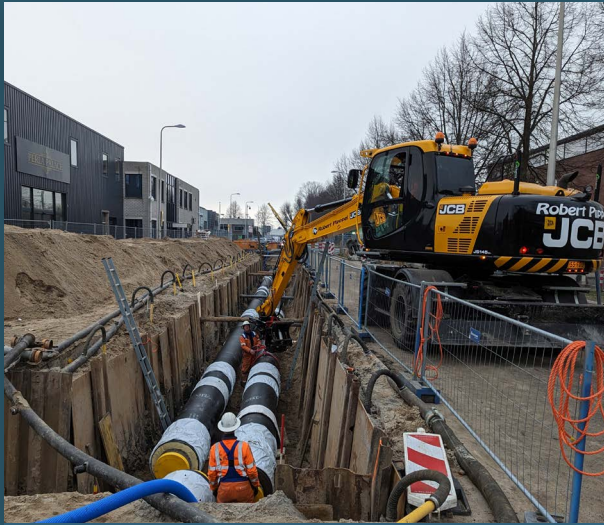
Aanleg van een transportnet
